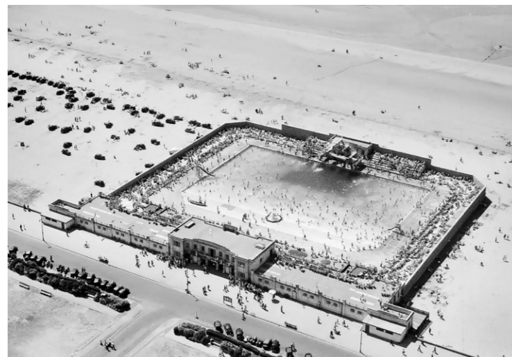
Figura 5. Fotografía aérea del complejo de Weston-super-Mare, en 1949. Material perteneciente al Historic England Archive (Aerofilms Collection).
