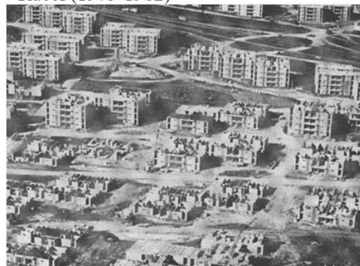
Fig. 12: Barrio Rucci en construcción (publicada en 1975)
