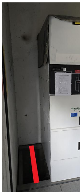
Figura 5: Esquematización de posición de patín en fosa.
