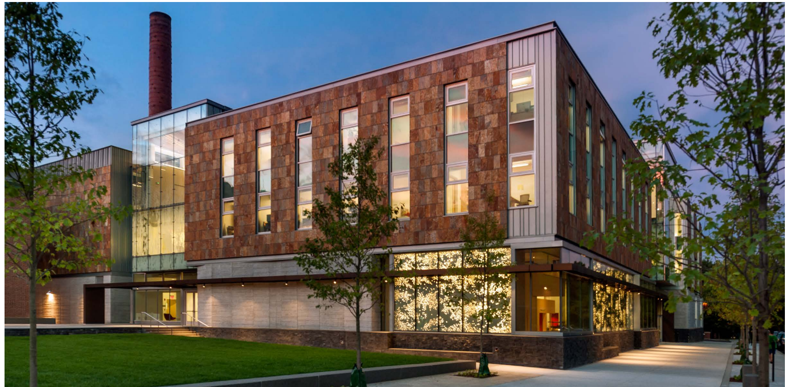
BFVAC. Vista del ángulo Sud Este del BFVAC adonde se encuentra la Galería de Arte, sobre la Calle Lebanon
