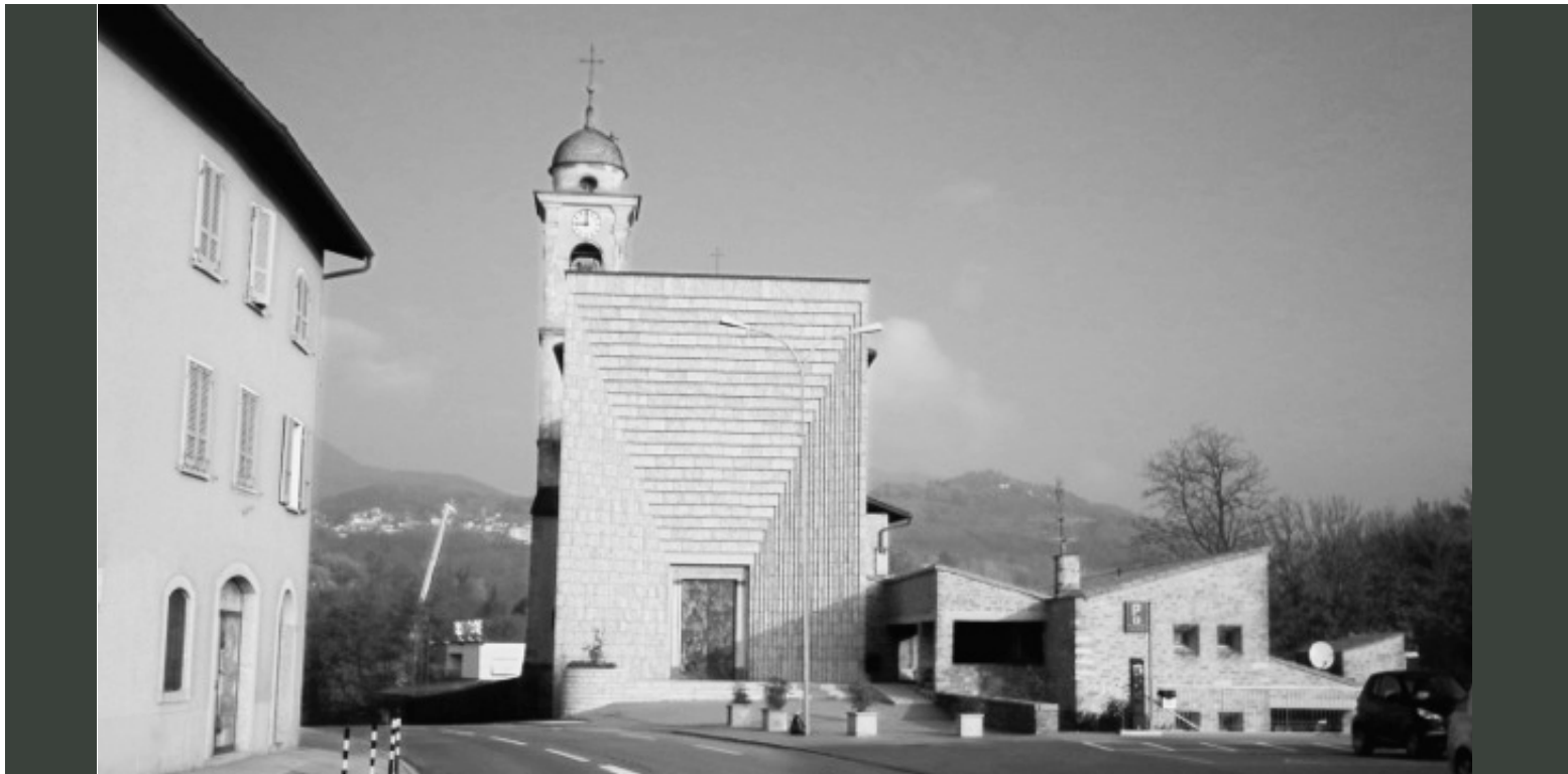
Iglesia de Genesterio, Nueva fachada- Suiza, 2003. M.Botta. Foto exterior (Realizada por los autores de la entrevista 2012)
