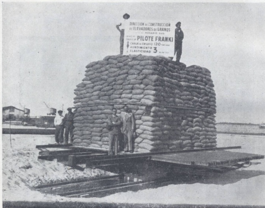
Fotografía N° 5. — Dispositivo del primer ensayo de carga FRANKI ejecutado en Rosario Sud.
