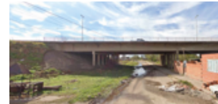
Lamadri cruce con Av. Circunvalación
