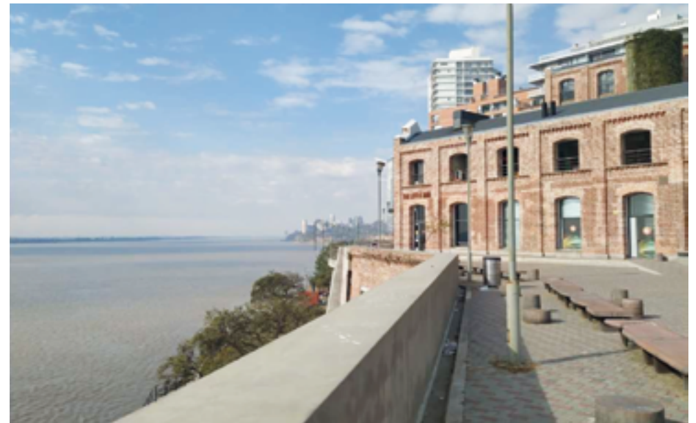
Acceso Público: Costa Alta "Puerto Norte"
