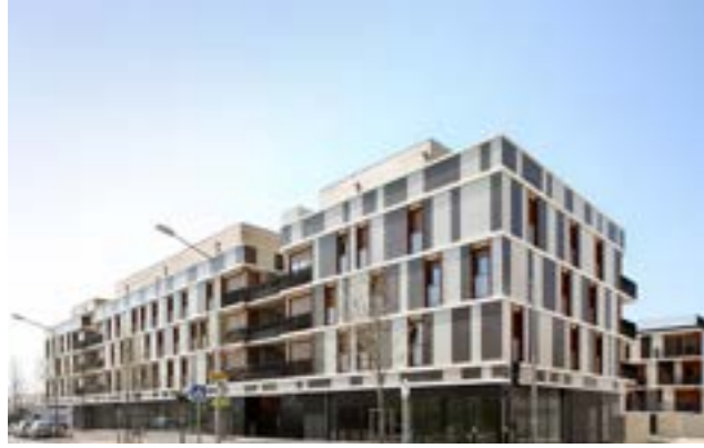
CONJUNTO DE VIVIENDAS VALENTON Arqs. Gelin - Lafon, Valenton Francia (2013)
