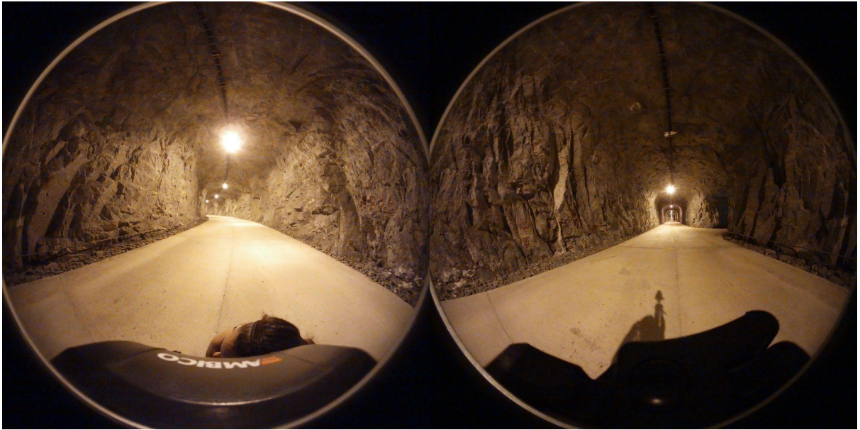
Figura 14: Foto esférica. (Fuente: propia).
