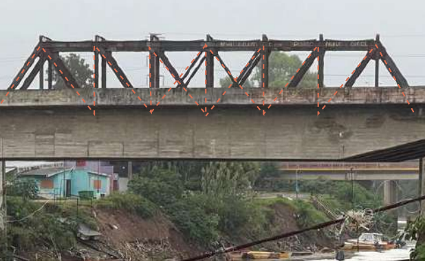
Puente ferroviario Saladillo
