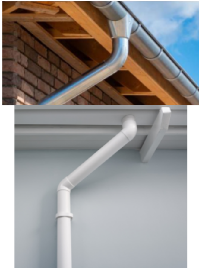
Figura 59. Ejemplo de canaleta de techo de zinc y cañería vertical de PVC
