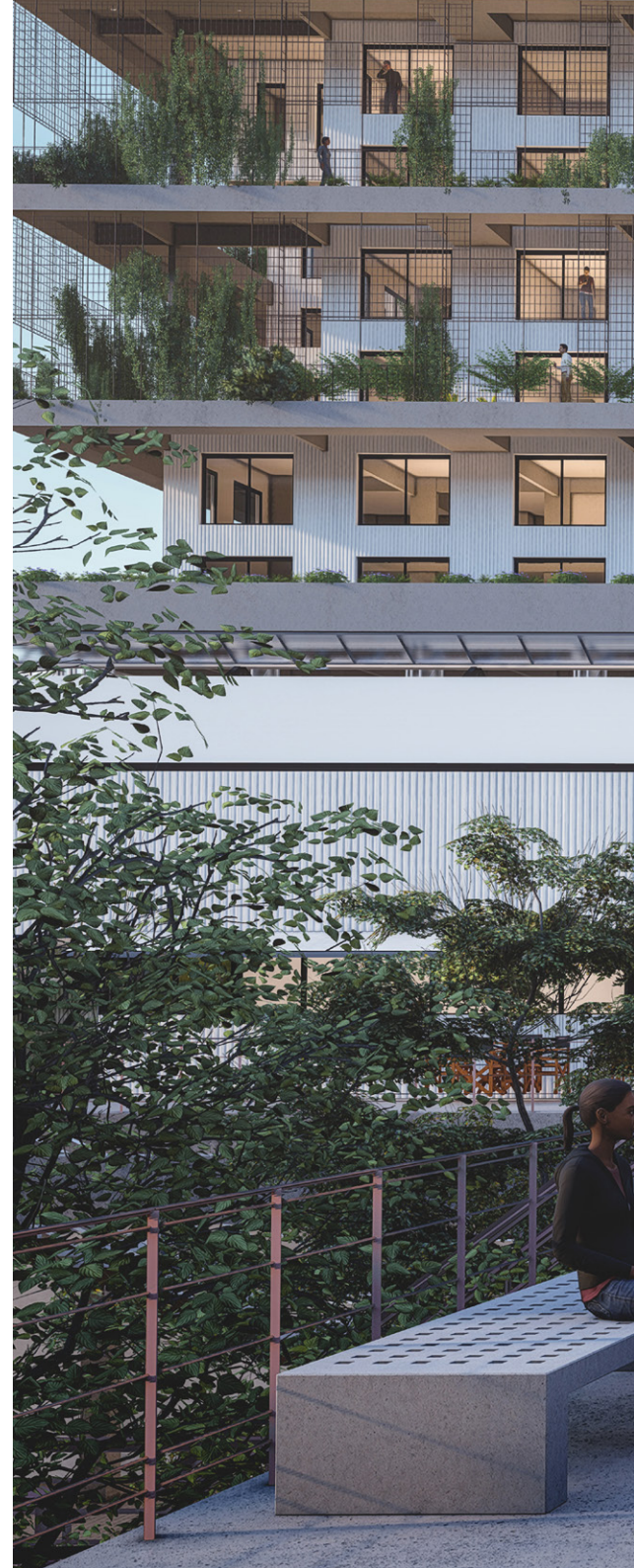
Equipamiento en cubierta
