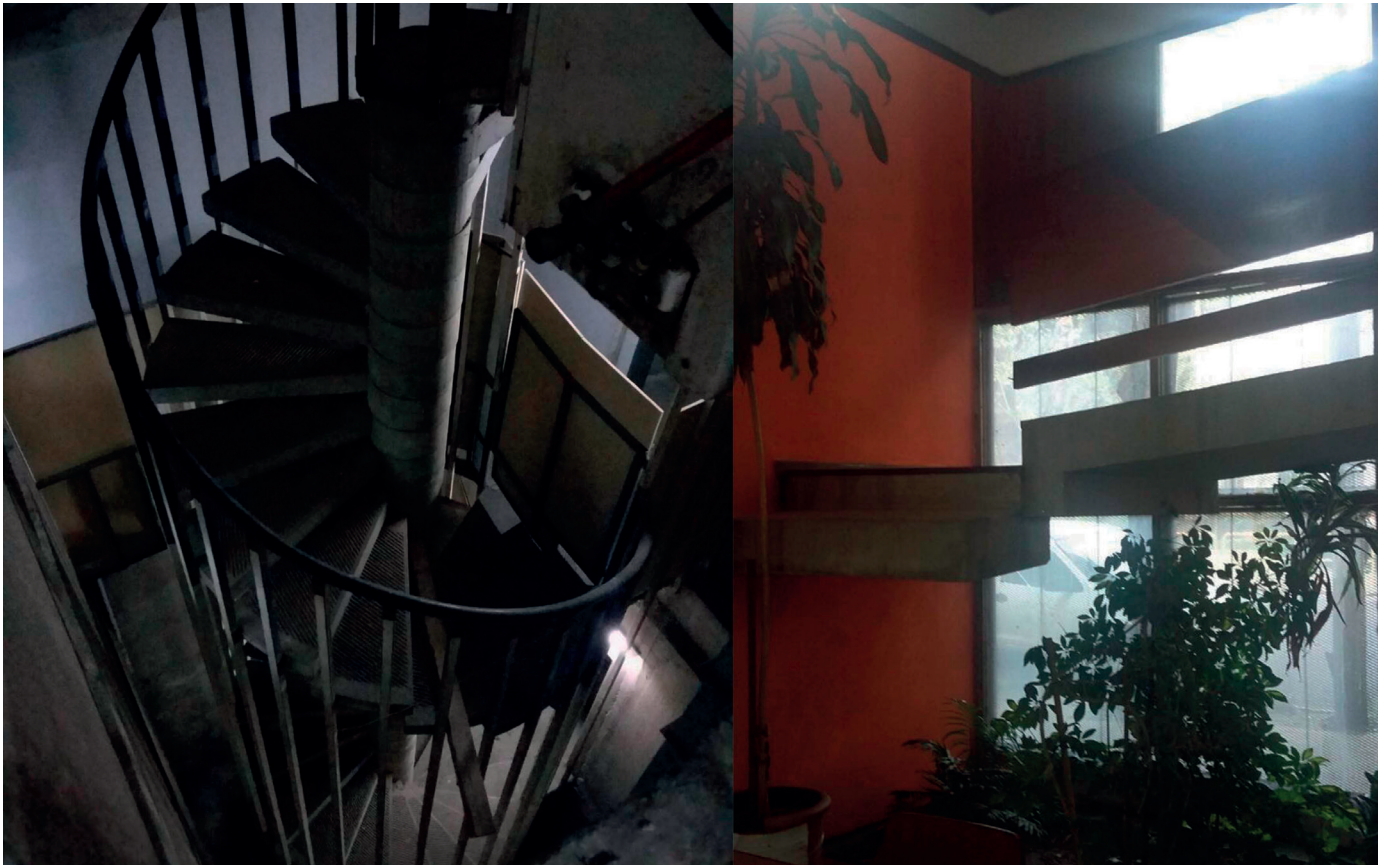
Imágenes actuales del edificio Alem y Gaboto.
