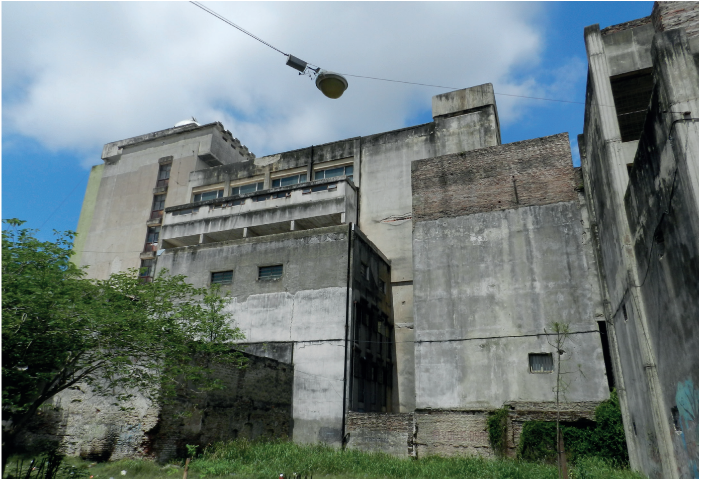
Imagen de medianera sobre Pasaje Perkins.
