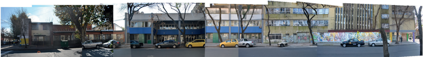
Imagen panorámica calle Gaboto entre Alem y 1ero de Mayo hacia el Norte.
