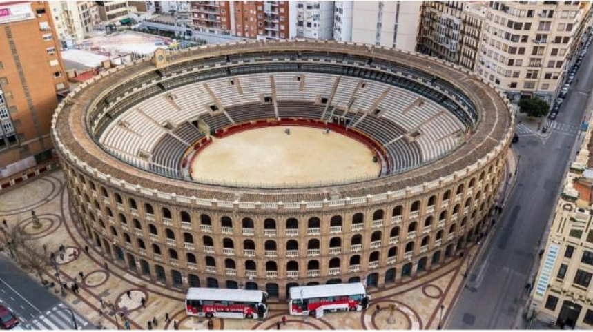
PLAZA DE TOROS, Valencia Peñin Arquitectos, año 2009
