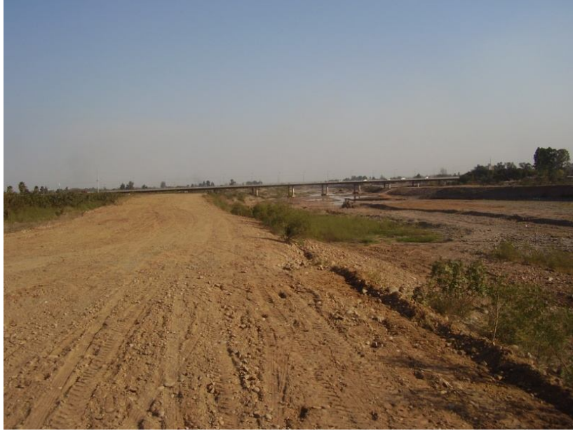
Figura 4.9, foto tomada desde aguas abajo hacia aguas arriba del Puente Lucas Córdoba, [Ref.(1)]. Fuente: proyecto de referencia realizado por la empresa de Norgav - 2007.
