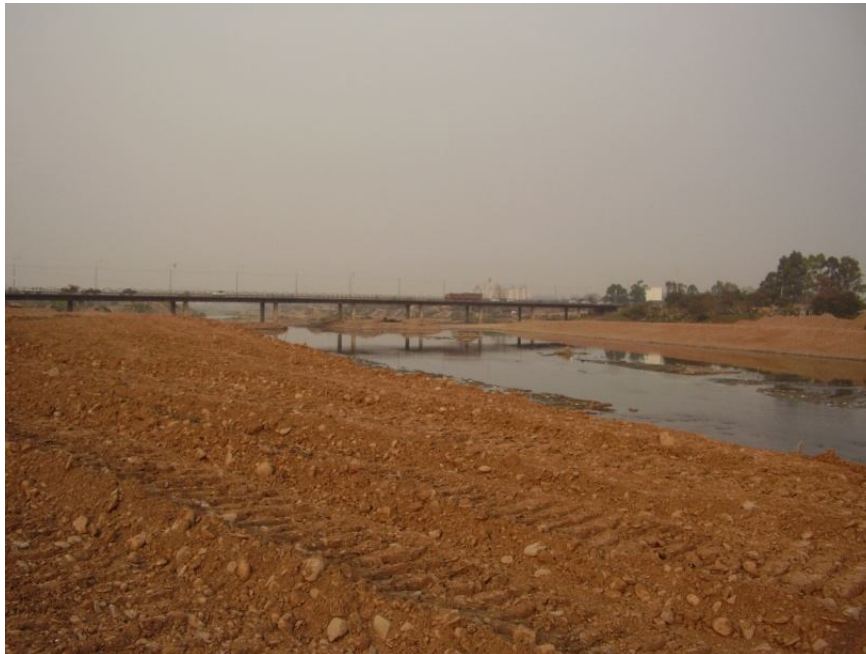
Figura 4.8, foto tomada desde aguas abajo hacia aguas arriba del Puente Oscar Barros, [Ref.(1)].
