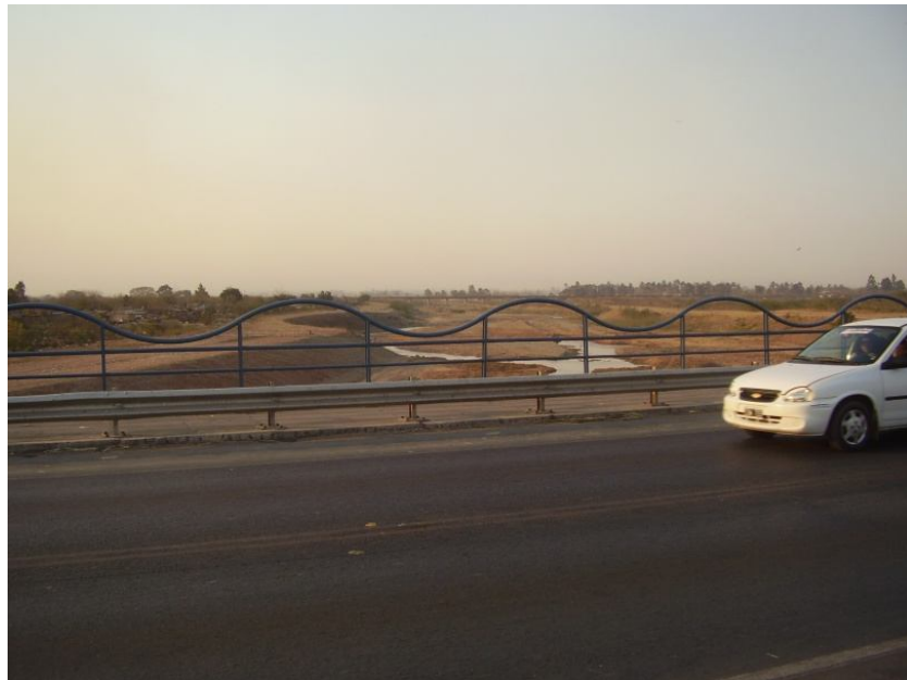
Figura 4.10, foto tomada desde el Puente San Cayetano hacia aguas abajo, [Ref.(1)]. Fuente: proyecto de referencia realizado por la empresa de Norgav - 2007.
