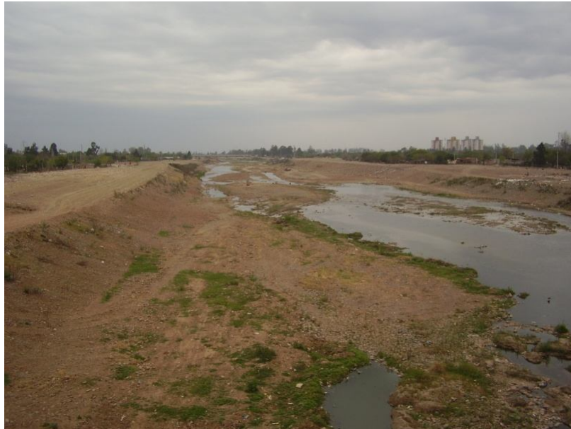
Figura 4.12, foto tomada desde el Puente San Cayetano hacia aguas abajo, [Ref.(1)]. Fuente: proyecto de referencia realizado por la empresa de Norgav - 2007.
