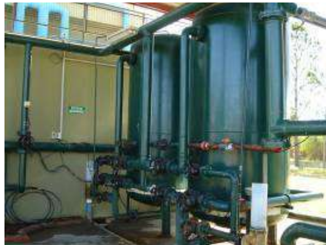
Figura A08: Planta Villa Ocampo – Sistema Remoción de Dureza
