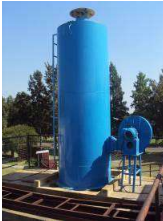
Figura A01: Planta Villa Ocampo Línea 01 – Aireador existente
