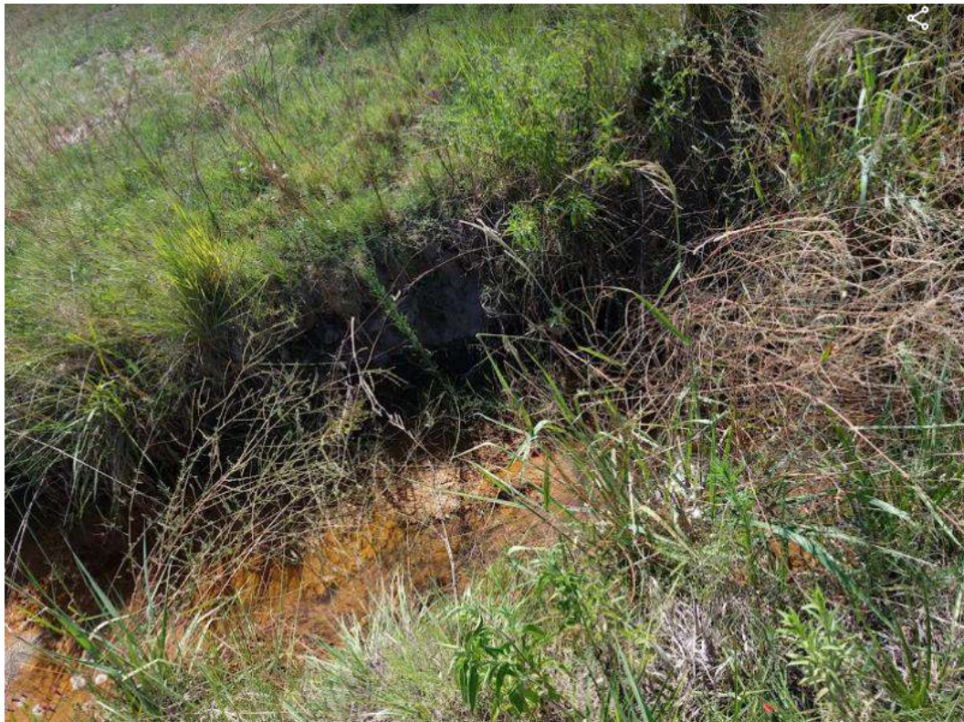
Figura 27 – Cuneta pluvial actual, fuera del predio – Fuente: Elaboración Propia, visita a la Planta por parte de los autores
