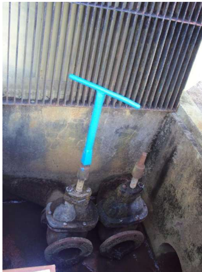
Figura A03: Planta Villa Ocampo Línea 01 – Purgas
