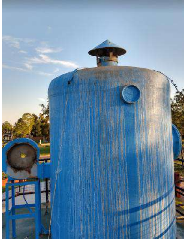
Figura 09: Planta Villa Ocampo Línea 02 – Aireador existente
