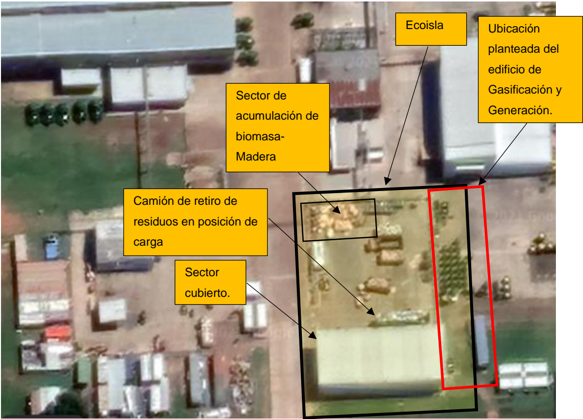
Figura 14: Detalle de la Eco-isla en la planta Fabril.
