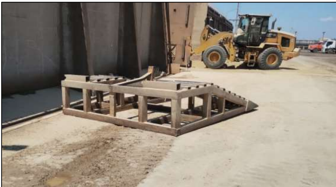
Imagen 12: Rampa metálica. Fuente: Propia.
