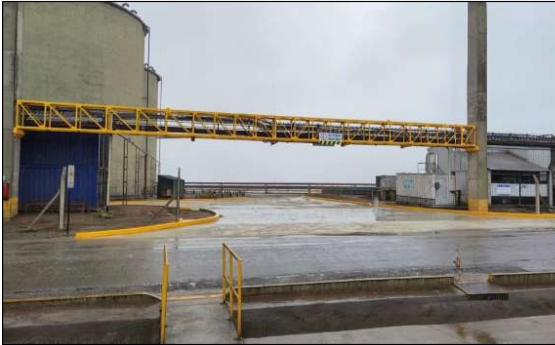
Imagen 24: Apertura de nuevo paso vehicular. Fuente: Propia.
