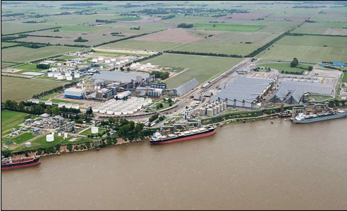
Imagen 4: Terminal industrial y portuaria. Fuente: Web Terminal 6 S.A.
