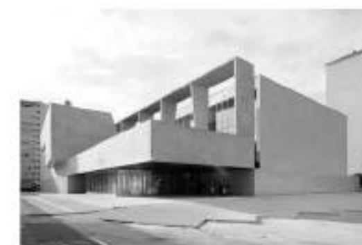
Extensión de Piscina en Bagneux Dominique Coulon 2014 / FRANCIA
