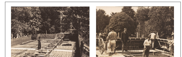
Delfina y Amancio Williams en obra, controlando armaduras y llenado de la losa. Fuente: AAW
