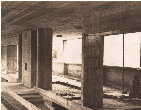
Los elementos estructurales internos quedarán integrados a una línea de mobiliario y placares disimulándose a la vista. Fuente: AAW
