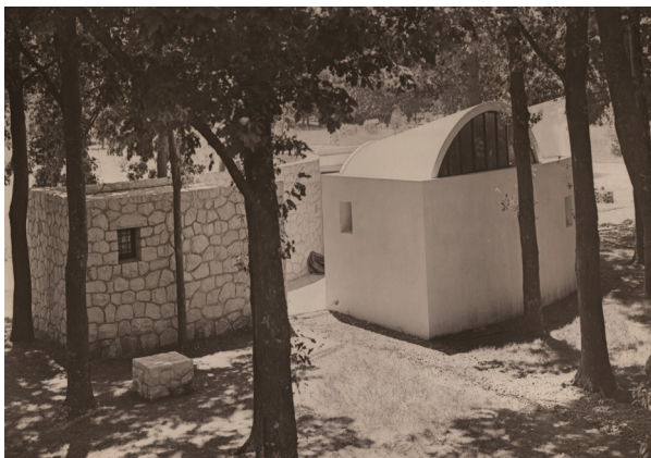
Pabellón de servicios y garage de la Casa sobre el arroyo. Fuente: AAW.
