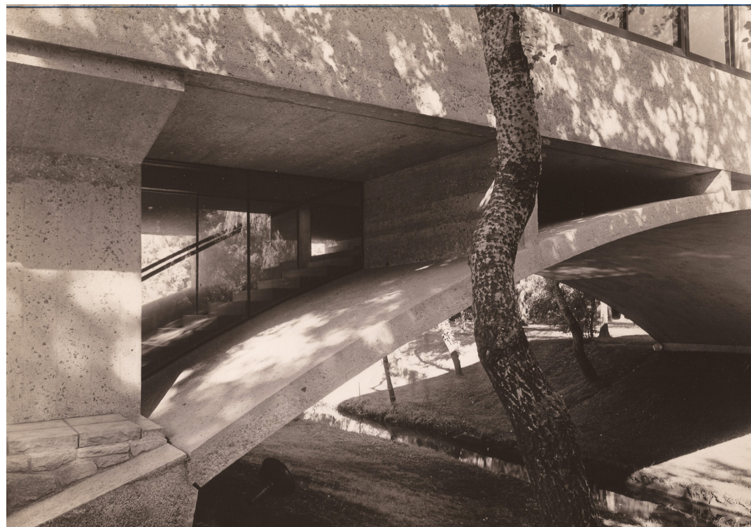
Detalle del martelinado y tratamiento de terminación del hormigón a la vista. Foto: Grete Stern. Fuente: AAW
