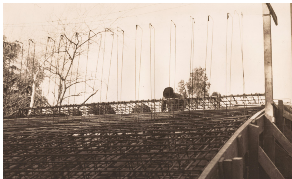
Armadura de hierro del arco y su enlace solidario con la viga de borde invertida. Fuente: AAW
