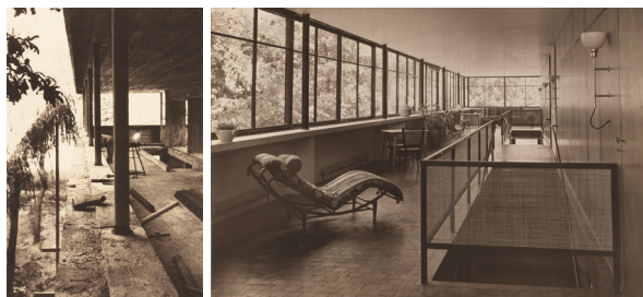
Detalle en obra de las columnillas metálicas que sostienen el perímetro de la losa superior y vista mostrando cómo en el resultado final se mimetizan con la carpintería. Fuente: AAW
