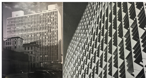
Lucio Costa y otros - Le Corbusier, consultor. Ministerio de Educación y Salud Pública. (Río de Janeiro, 1937-1942). Vista general y detalle del Brise soleil de la fachada noroeste. Fuente: Philip L. Goodwin, Brazil Builds . pp. 107-84.
