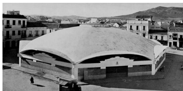
Eduardo Torroja, cúpula del Mercado de Abastos de Algeciras (1933). Fuente: TORROJA CAVANILLAS, José A. Eduardo Torroja. Revista I.T. (79): 90-103, p. 99.
