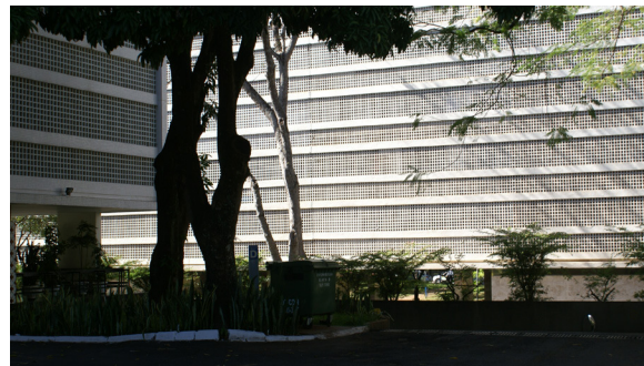
Adaptación del motivo del "cobogó" a los bloques de departamentos de las "supercuadras" en Brasília. Fotografía: Luis Müller.
