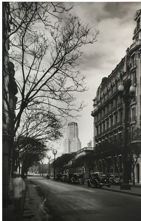
Edificio Kavanagh (al fondo) visto desde la Av. Santa Fe. Fotografía: Horacio Coppola, 1936. Fuente: MONZÓ, Josep Vicent [Coord.]. El Buenos Aires de Horacio Coppola . Valencia : IVAM, Centre Julio González, 1996. p. 20.
