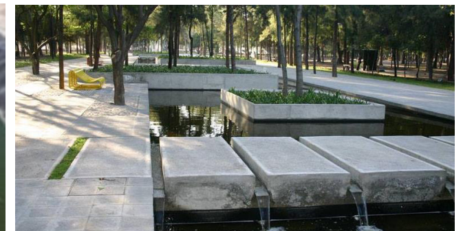
DEPÓSITOS DE RETENCIÓN
