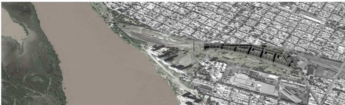
Vista aérea del conjunto.
