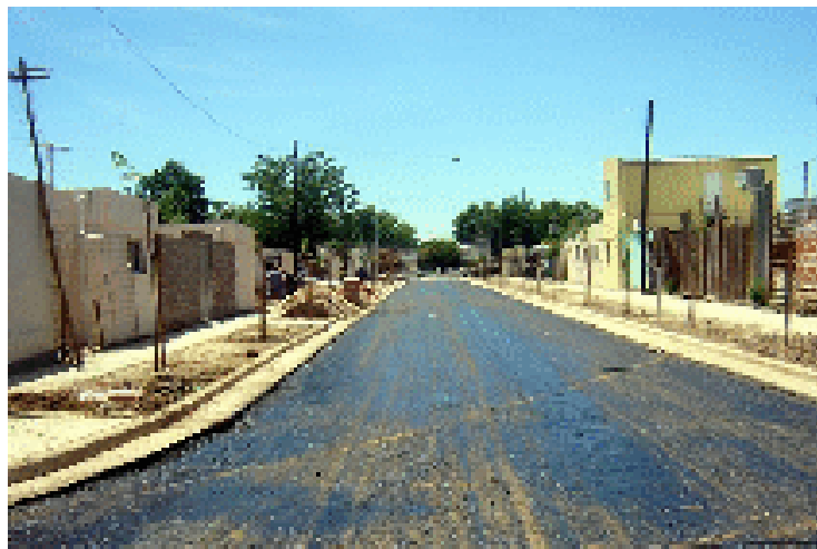
Espacios públicos y reordenamiento urbano: Antes y Después. Relocalización de viviendas para liberar espacio para la posterior pavimentación y construcción de veredas. Conformación del domicilio.
