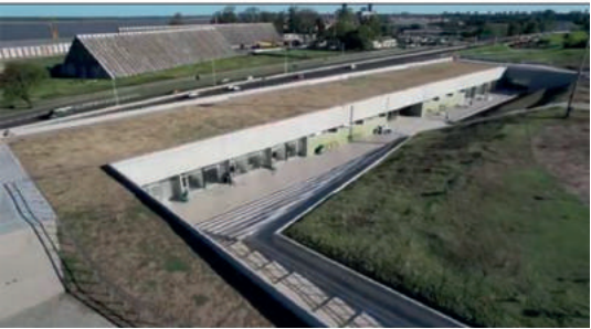
Aulario Nuevo Edificio. C.U.R (2021)
