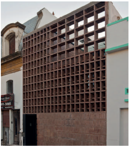
Casa de Ladrillos / Ven- tura Virzi arquitectos (2011)
