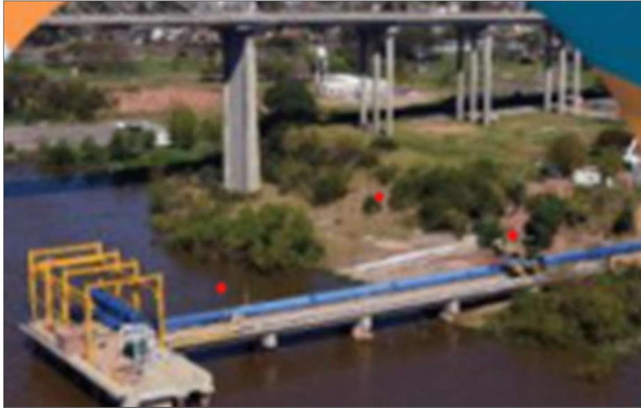
Fig 11.Imagen toma de captación y conducción (PPGB)
