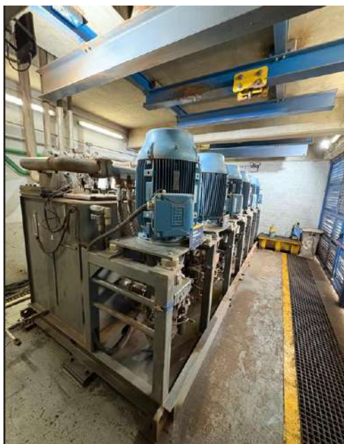
Figura 1-3: Interior del recinto hidráulico.
