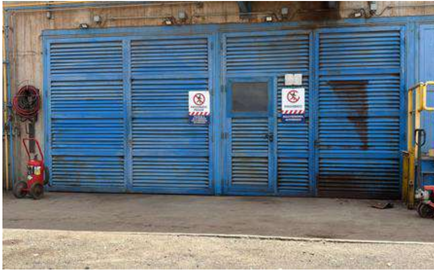
Figura 2-3: Acceso al recinto.
