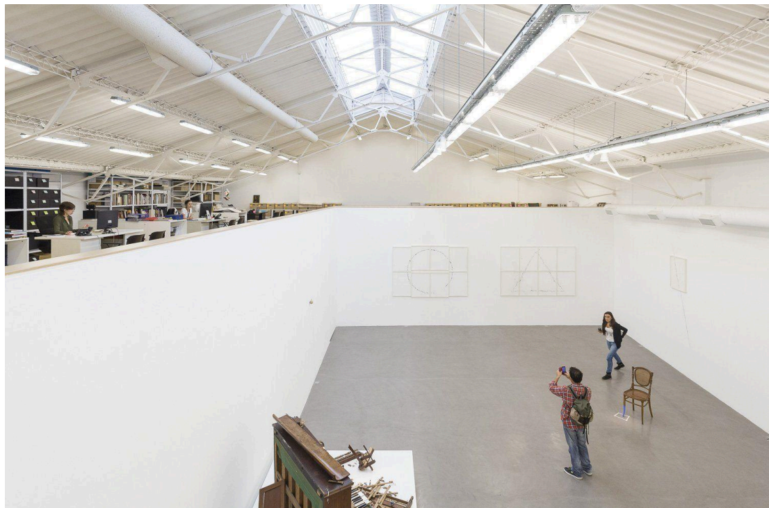
Vista de la sala de galería Ruth Benzacar en Villa Crespo. En la fotografía se puede observar el amplio galpón refuncionalizado con una sala de exhibiciones en su planta baja que posee paredes de durlock y pisos de cemento alisado; y un entrepiso en el que se encuentra un espacio de trabajo con trastienda y archivo. La fotografía fue tomada del archivo de la galería Ruth Benzacar, Rojas, J. A. (2015).
