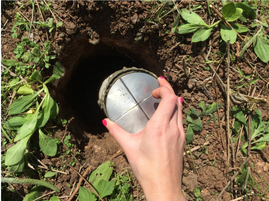
Figura 44: Una vez puesto el hormigón se procede a poner la placa identificadora.
