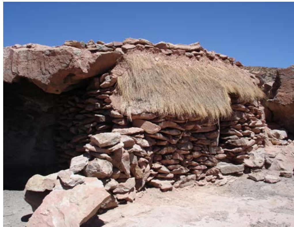
Detalle de un puesto adosado a un alero. Fotografía propia.
