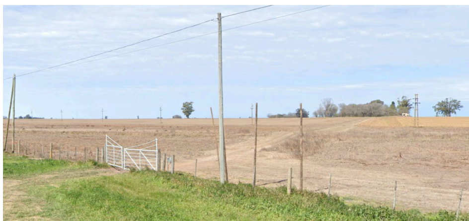
Fig. N°66. Interferencia de camino de ingreso a campo.
