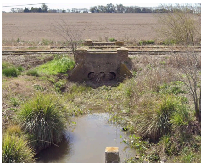
Fig. N°8. Estado actual de Alcantarilla N°3. Fuente: Google Earth.
