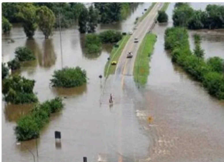
Fig. N°4.1. Imagen aérea de cortes por inundación del tramo en estudio.
