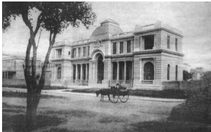
Facultad de Cs. Médicas – Rosario – 1910 - Estilo historicista neo-renacentista – Ingreso norte hoy demolido.
