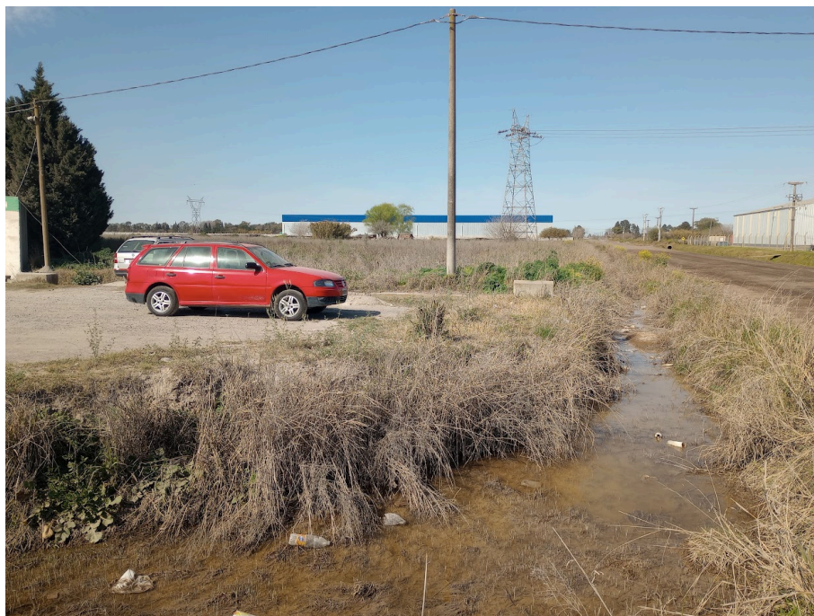
Foto 2: Condiciones actuales del canal de descarga.
