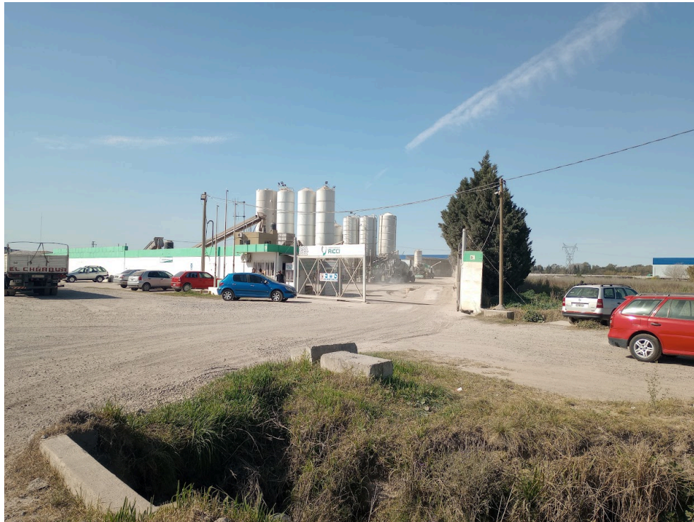
Foto 5: Único acceso actual a la planta.
