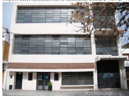
F45: Edificio Lagos – Imagen: commons.wikimedia.org
