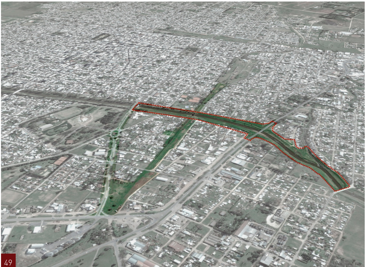
F92: Área de intervención en el Paseo Peatonal del Terraplén – Imagen de autoras
