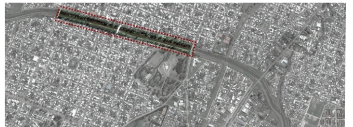
F91: Paseo Peatonal del Terraplén - Imagen de autoras
