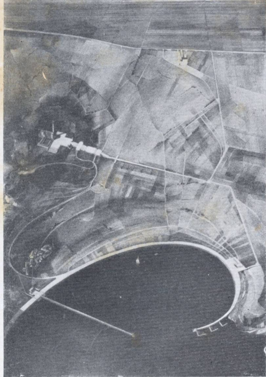
VISTA AEREA DEL CONJUNTO
