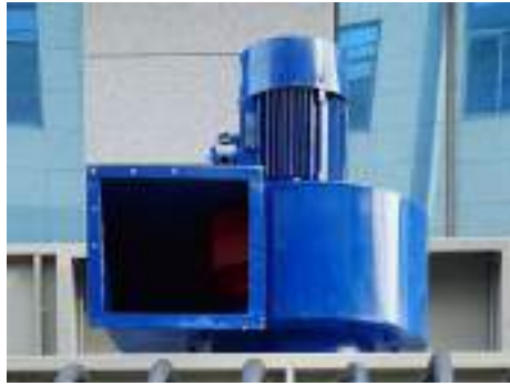
Figura 5-9: Ventilador para direccionar el polvo a recuperar hacia los filtros.
