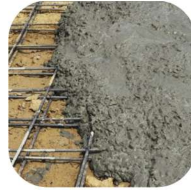
Estructura de hormigon armado Pilotis Columnas Losas Tabiques estructurales
