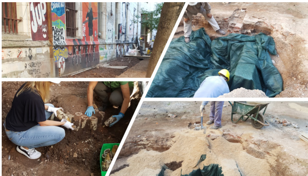
Figura 12. Retiro de botellas de gres que conformaban el contrapiso. Relleno y recubrimiento con el geotextil del sector bóveda, 2019.
