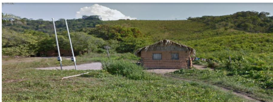
Ilustración 41 - Casa de barro y cubierta de paja en la comunidad de Murumutuba.
