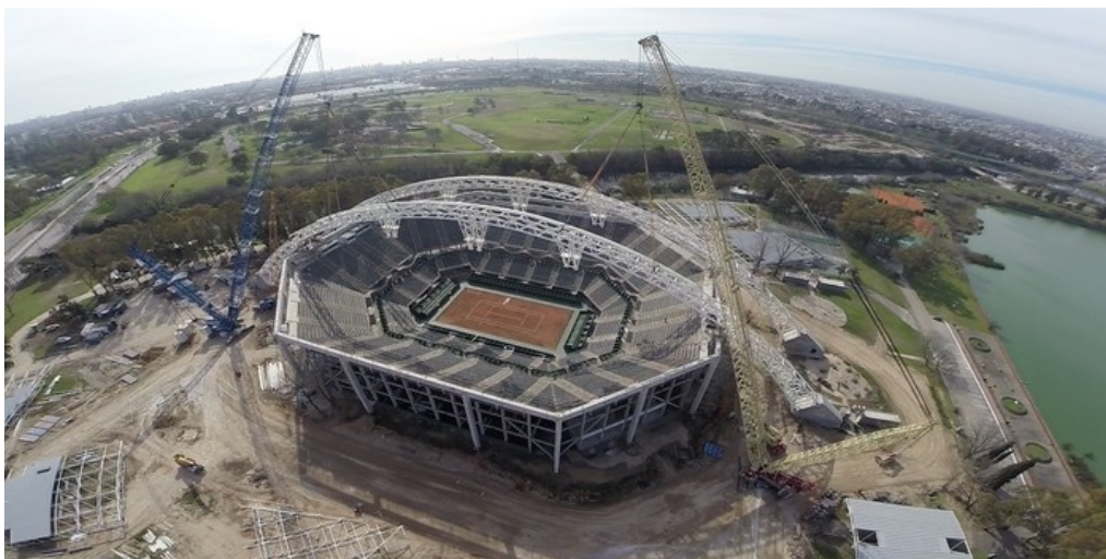
Ilustración 45 – Foto de la construcción del Estadio Parque Roca Fuente: Summa+ N° 93, Estadio Parque Roca. 13 de abril de 2009.
