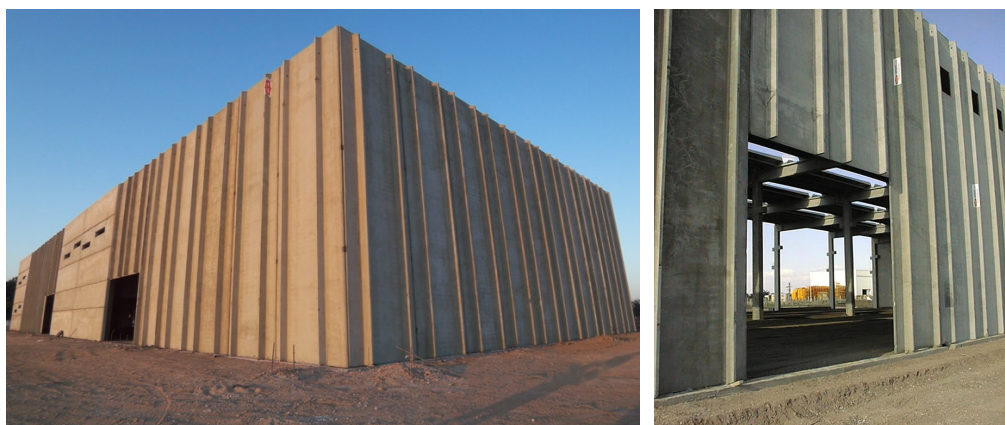
Ilustración 12 – Edificaciones con cerramiento nervurado de Astori. Fuente: Astori Estructuras S.A. (n.d.). Fotografías [Conjunto de fotografías de obras realizadas con paneles de cerramiento nervurado]. Recuperado de https://www.astoriestructuras.com.ar/sistemas/cerramientos-nervurados .
