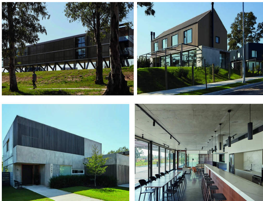
Ilustración 18 – Sistema constructivo de viviendas. Fuente: Astori Estructuras S.A. (n.d.). Fotografías [Conjunto de fotografías de las obras realizadas con el sistema constructivo de viviendas]. Recuperado de https://www.astoriestructuras.com.ar/sistemas/sistema-constructivo-de-vivienda .
