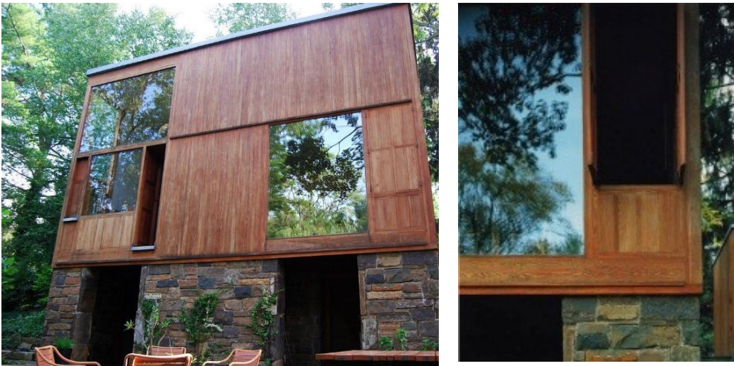
Fachada noreste y detalle. Fuente: Pierson Booher
