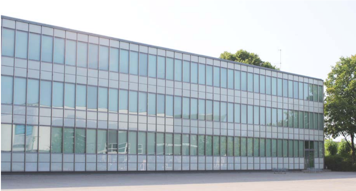
Fachada libre modulada a partir de una grilla neutra. Este frente no revela el sistema de sostén. No alude ni deja percibir la presencia de las vigas ni de las columnas. Fuente: imagen de la autora.
