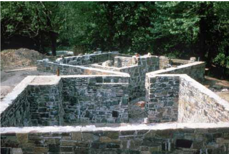
Foto del basamento en construcción. Fuente: cortesía familia Fisher.
