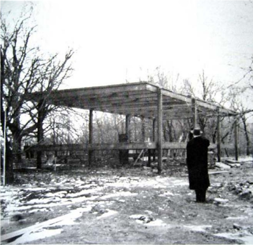
Mies van der Rohe de pie frente a la estructura de la Casa Farnsworth,
