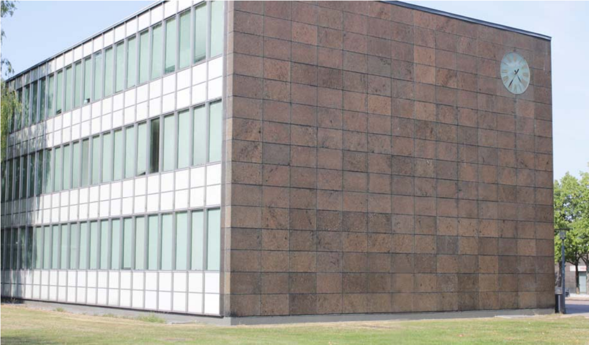
Los extremos longitudinales del edificio principal y los transversales del secundario se encuentran revestidos de piedra natural negra de Sølvgag. Fuente: imagen de la autora
