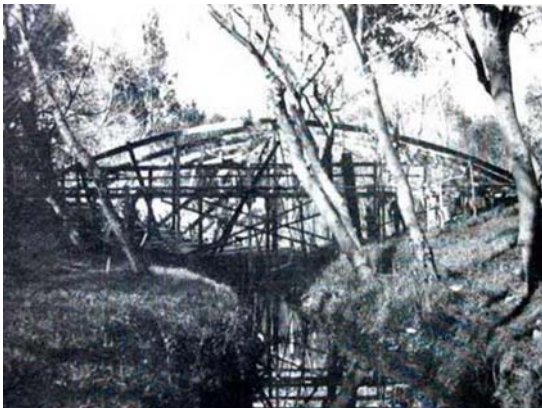
Encofrado y base del puente
