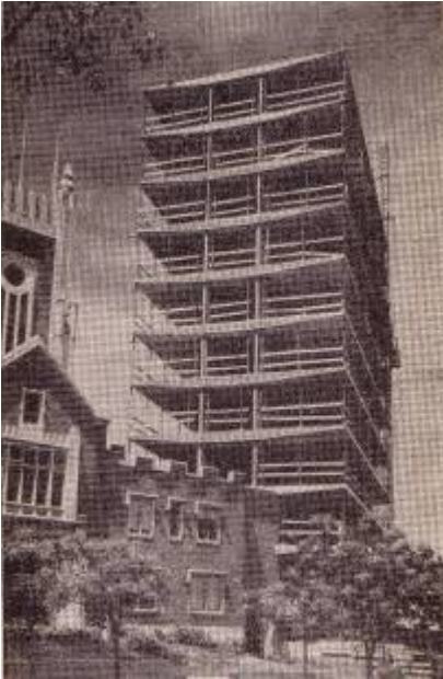
Edificio Positano en obra CEDA nº 29, diciembre de 1965.
