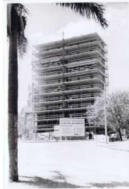
El Positano en obra.
