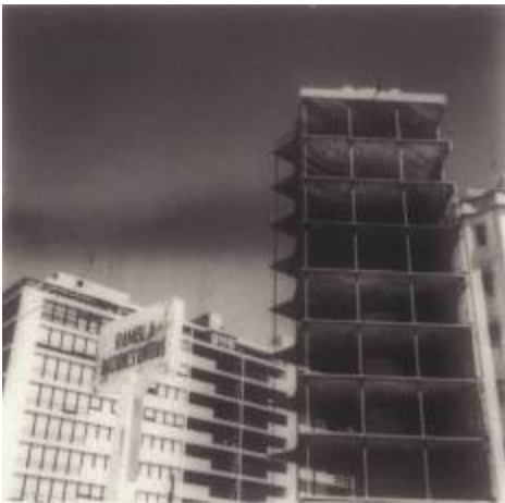
El Pilar en obra.
