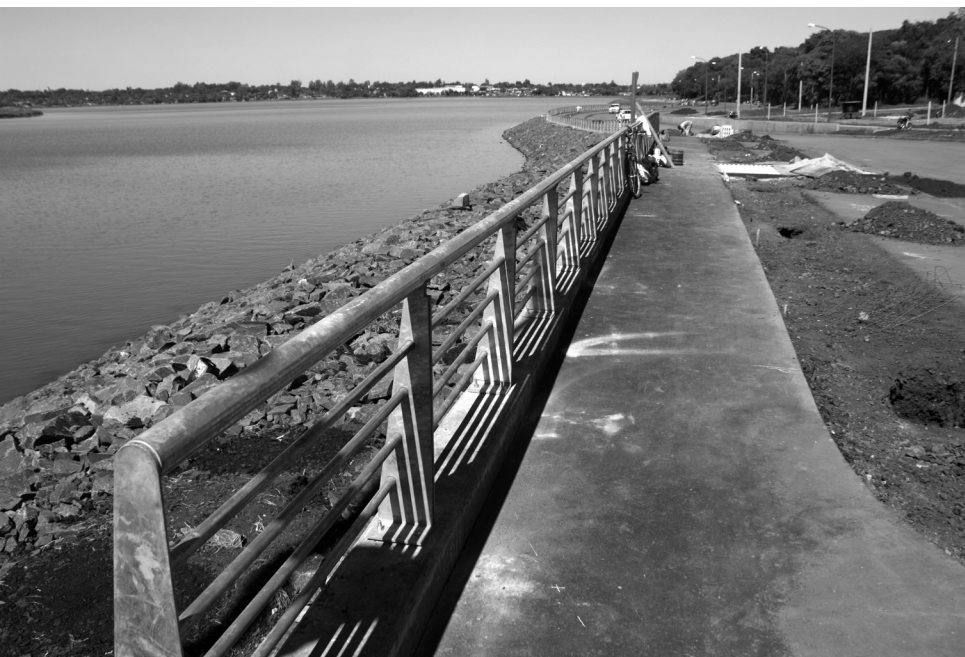
1. La Costanera en construcción - Fecha: 2012 - Foto: Carlos Salamanca
