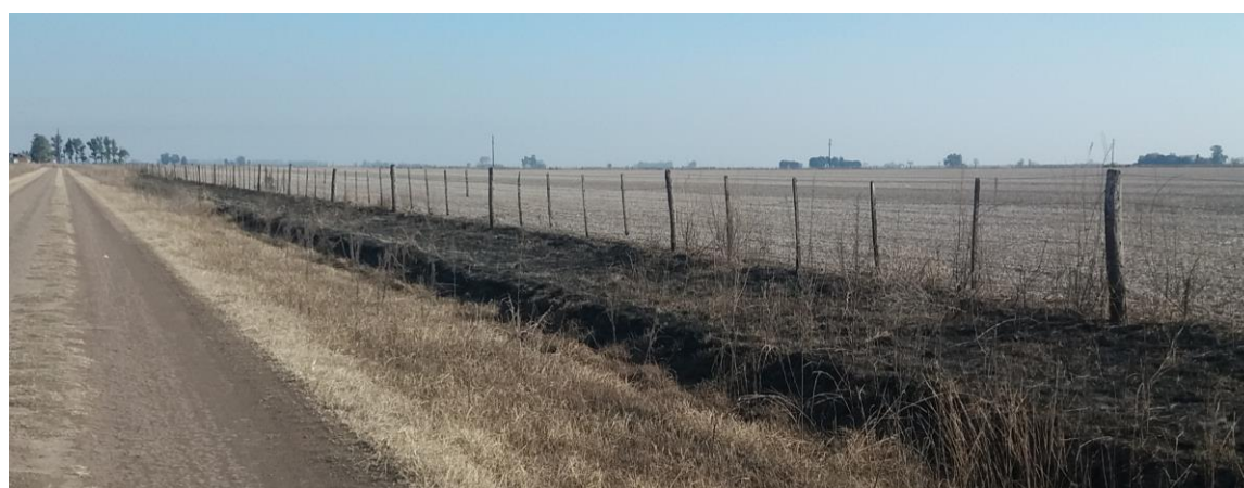
Figura 40: Tratamiento diferencial entre cunetas y alambrados, Tramo B002 (04/19). Elaboración propia
