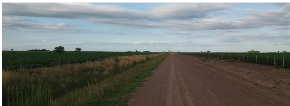
Figura 39: Tratamiento diferencial entre cunetas y alambrados, Tramo B003 (04/19). Elaboración propia
