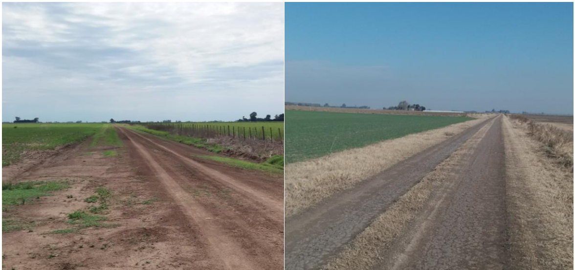
Figura 37: Falta de alambrados en diferentes sectores del Tramo B002. Elaboración propia
