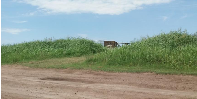
Figura 33: Vegetación que afecta la visibilidad en intersecciones, Tramos 23-s (08/20). Elaboración propia
