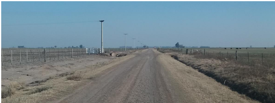
Figura 38: Tratamiento diferencial entre cunetas y alambrados, Tramo A03 (04/19). Elaboración propia
