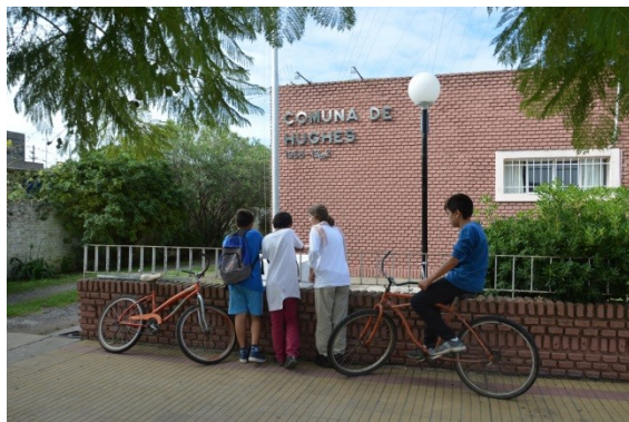
Foto 1: Vista del frente del edificio comunal
