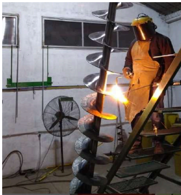
Figura 1-13: Automatismo para la rotación del tornillo sin fin. [ Fuente: Cementados Zona Campo ]
