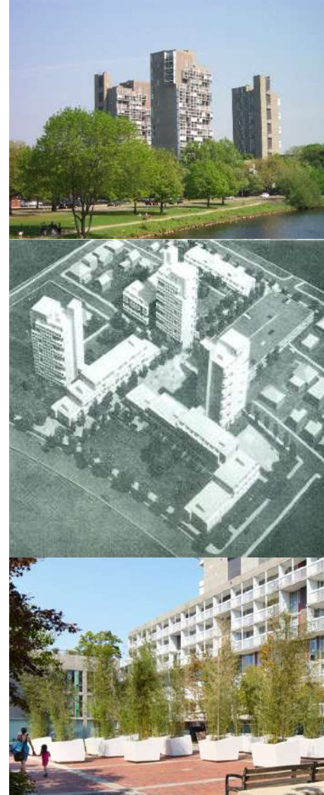
Proyecto: Peabody Terrace Arquitectos: Josep Lluís Sert Ubicación: Cambridge, EEUU
