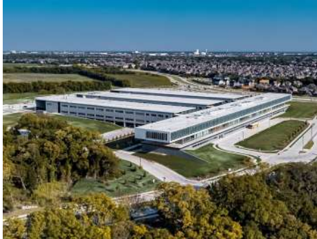
Proyecto: Collin College Arquitectos: Perkins & Will Ubicación: Texas, EEUU
