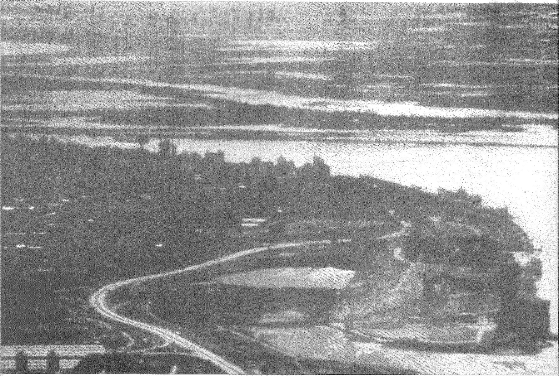
Vista aérea del ámbito a ser afectado por la conexión ROSARIO-VICTORIA
