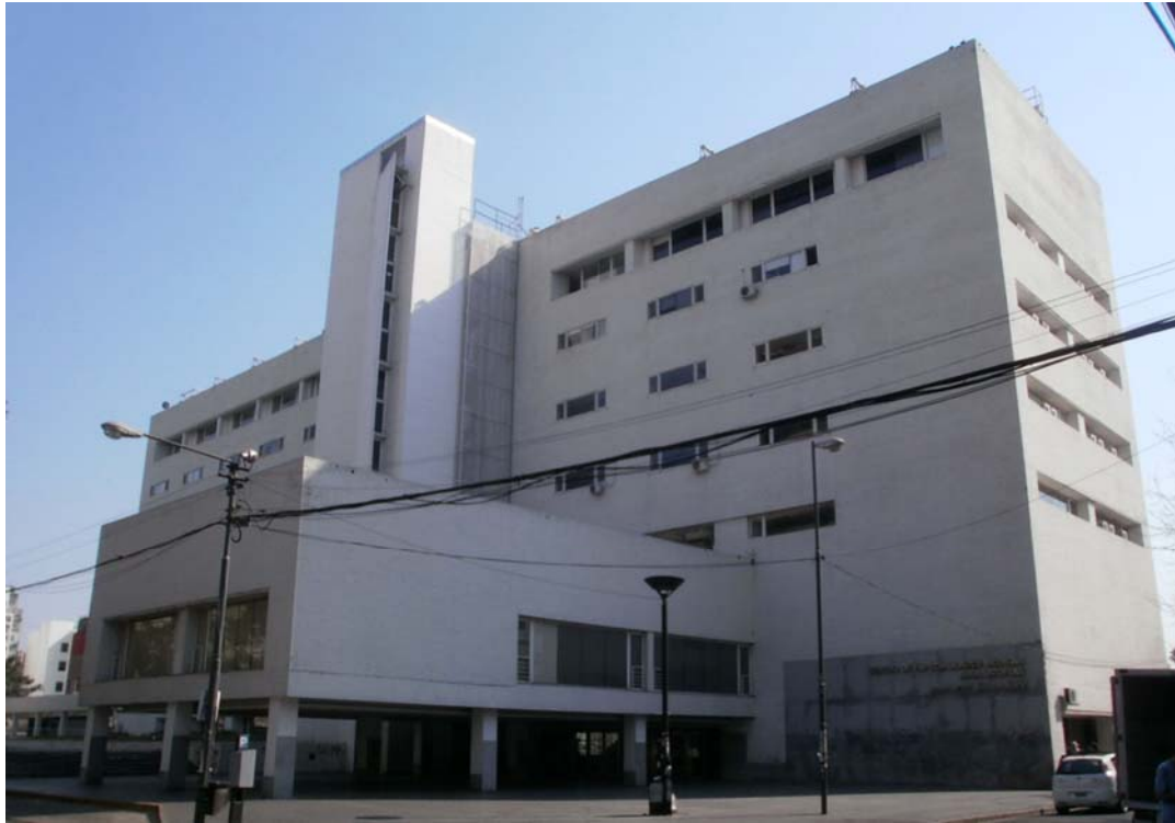
Imagen 3. Edificio CEMAR Fachadas Sur y Este.
