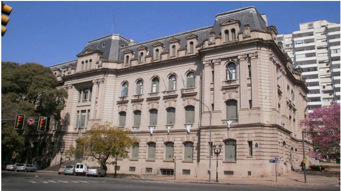
Imagen 1. Edificio Ex Aduana. Fachada Noroeste.
