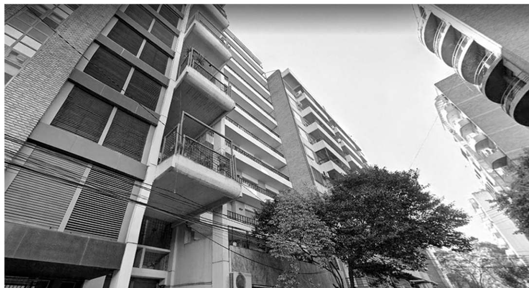
“Edificio de calle Pte. Roca 262 - Rosario”
