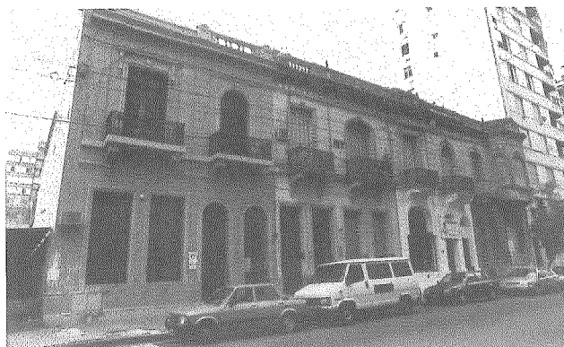
Vista estado actual
