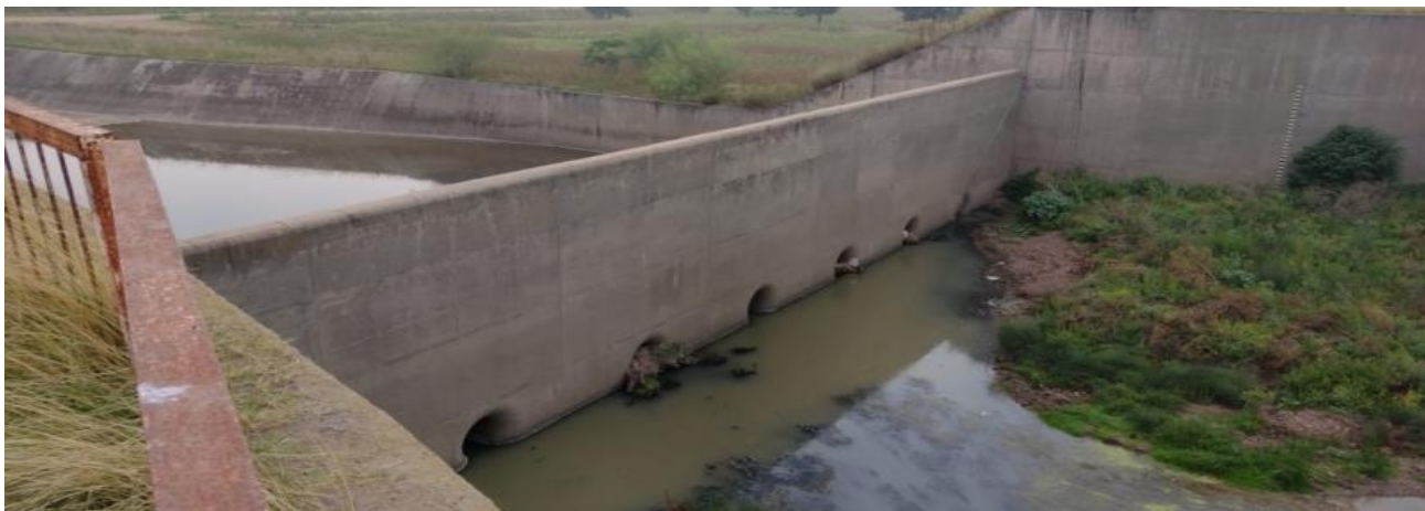
Foto 16 y 17: Imágenes del vertedero y de la descarga de la represa. Fuente: Fotografía de mi archivo personal.
