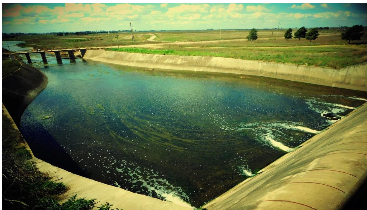
Foto 14: Imagen de la Represa del arroyo Ludueña. Fuente: Fotografía de mi archivo personal.
