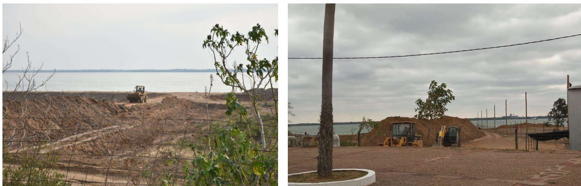
Figura 7.18. Maquinas trabajando en el relleno. Fuente: izq: Mega 98.1. (11 de septiembre de 2020); der: Carbono News, 7 de septiembre de 2020.
