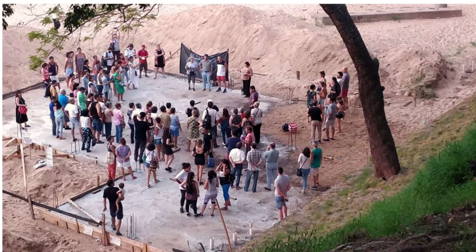
Figura 7.13. Manifestación de los DC en platea de hormigón en Playa Islas Malvinas II para parador MS Holding Group. Fuente: Gentileza de Defensores Costeros.
