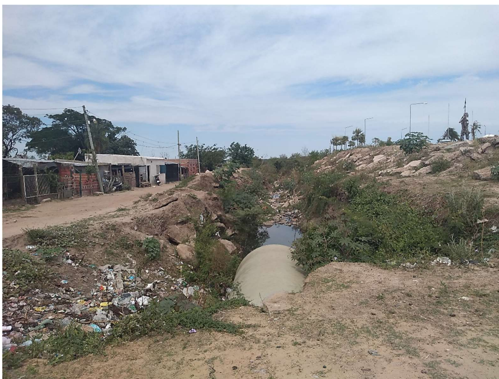
Figura 7.19. Canal aliviador donde transcurren parte de las aguas del Arroyo Limita Entubado bajo la Av. Romero. Fuente: Elaboración propia.
