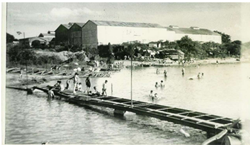
Figura 5.1. Espacio para bañarse en el río donde se encontraba la toma de agua, recinto de Molinos Río de la Plata en la década del 60. Fuente: Fototeca del Archivo Histórico Provincial de Corrientes.
