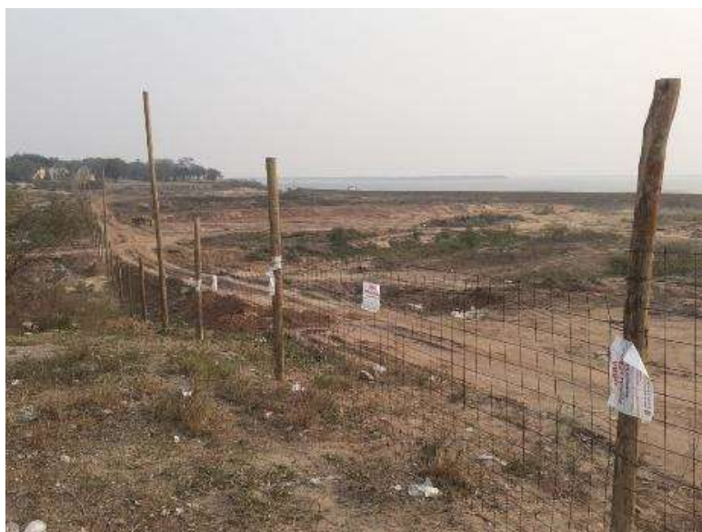
Figura 7.15. Imágenes aéreas del área de relleno (tomadas mediante drone). Fuente: Gentileza de Arenera del Litoral a DC.
