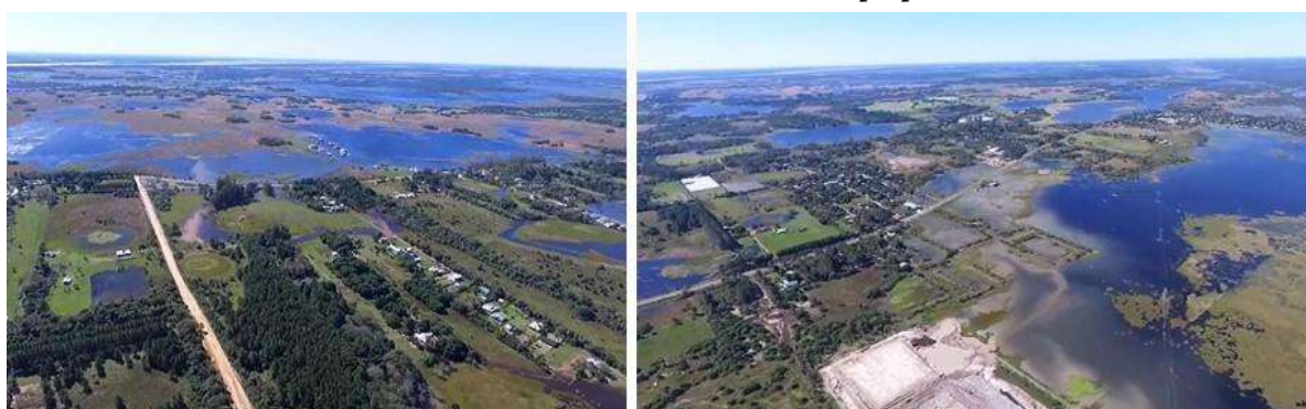
Figuras 8.11. (Izq.) Territorio de Avance Clubes de Campo al norte de Ruta 5 - (Der.) Anegamiento de barrios sobre Ruta 5. Fuente: Municipalidad de Corrientes, en El litoral, 28 de abril de 2017.
